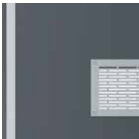
grilă de ventilație
