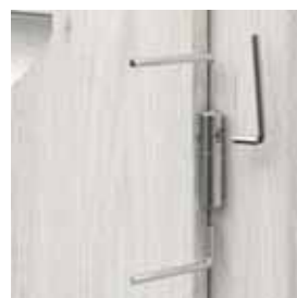
ajustarea balamalelor reglabile 3D
