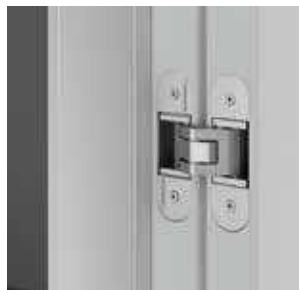
balama 3D (ușa deschisă)
