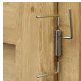
ajustarea balamalelor reglabile 3D
