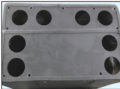
Scheme 7. Demontarea capacului pentru țevile de fum-2
