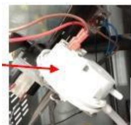
Comutator de presiune al coșului în centrala
