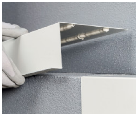
Lipirea flexibila a elementelor de constructii si a accesoriilor
