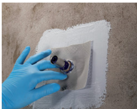
Aplicarea piesei speciale Mapeband PE 120 pentru tevi utilizand Mapegum WPS
