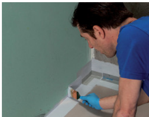
Aplicarea benzii Mapeband PE 120 folosind Mapegum WPS
