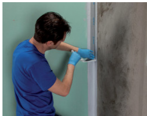
Aplicarea benzii Mapeband PE 120 folosind Mapegum WPS
