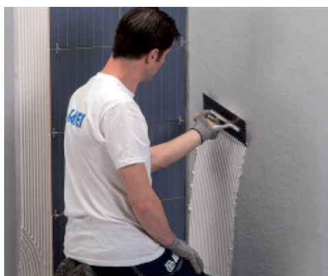
Montajul plăcilor ceramice pe pereti utilizand Keraflex Maxi S1
