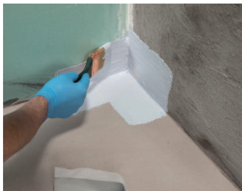
Aplicarea piesei speciale Mapeband PE120 pentru unghi de 90° folosind Mapegum WPS
