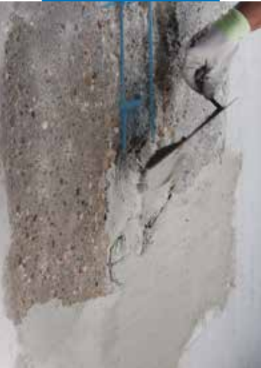
Aplicarea Planitop Rasa & Ripara cu o mistrie
