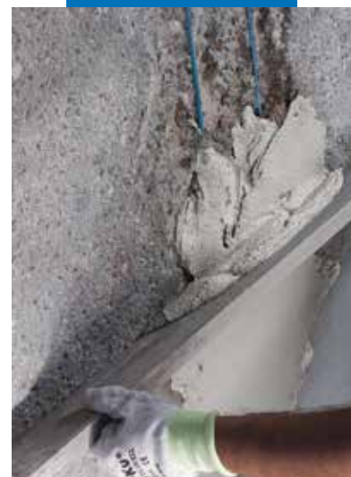
Nivelarea mortarului Planitop Rasa & Ripara cu un dreptar
