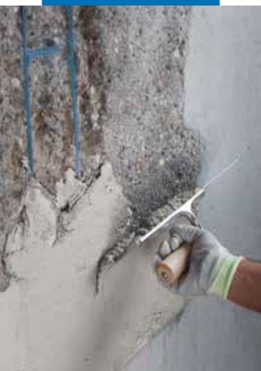
Aplicarea Planitop Rasa & Ripara cu o gletieră
