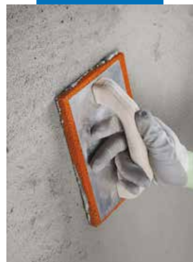
Drișuirea mortarului Planitop Rasa & Ripara
