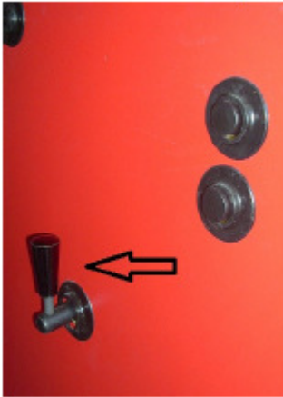
Figura 15. Pozitia manetei clapetei pentru – APRINDEREA FOCULUI
