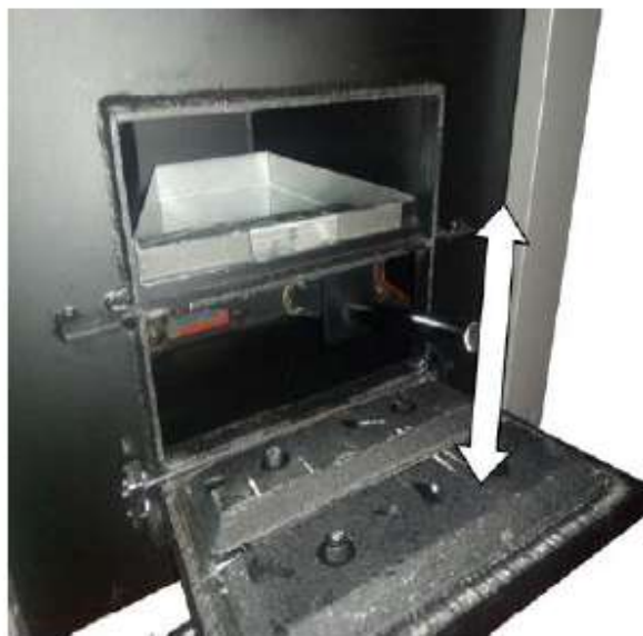
Figura 19. Curatarea turbulatoarelor de pe cazan
