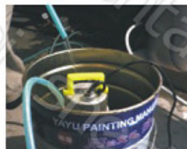
Utilizarea pompei pentru umplerea cu agent termic
