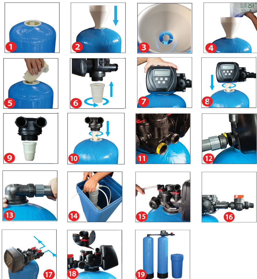
Fig 3. ETAPE INSTALARE STATII SOFT TWIN
