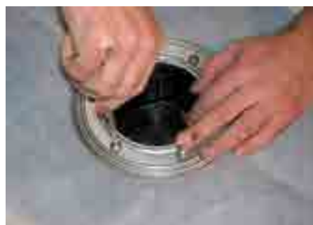
5. Flanșa din oțel inox se înșurubează la corpul receptorului, închizând etanșarea
