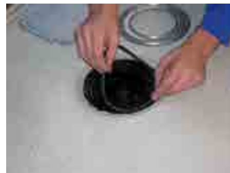
3. Se înlătură protectorul de construcție, se așează inelul de etanșare se începe montarea foliei
