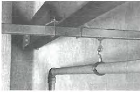
Figura 36. Exemplu de fixare șină de montaj pe profil laminat, cu cleme TKR
