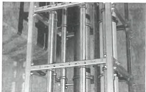
b) schelet de susținere din șine de montaj îmbinate la colțuri cu vinclu universal UWS
