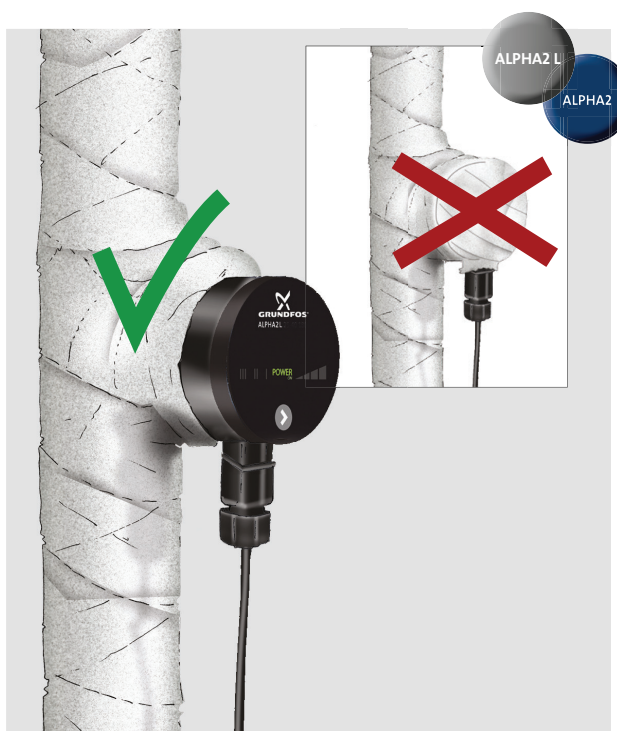
Fig. 5 Izolarea carcasei pompei
