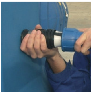
Conectarea tubului din polietilena
