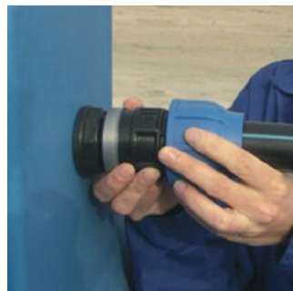
Montarea corpului racordului de compresie
