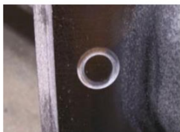
Fig. 2 Gaura pentru baterie/vedere de sub chiuveta
