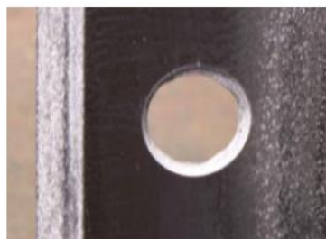
Fig. 6 Gaura finisata vazuta de sub chiuveta
