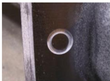
Fig. 2 Gaură pentru baterie/vedere de sub chiuveta
