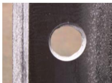
Fig. 6 Gaură finisată văzută de sub chiuveta
