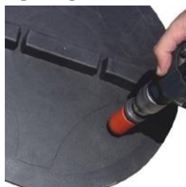
Se realizează o gaură pe capac cu o bormașină cu freza 32 mm.
