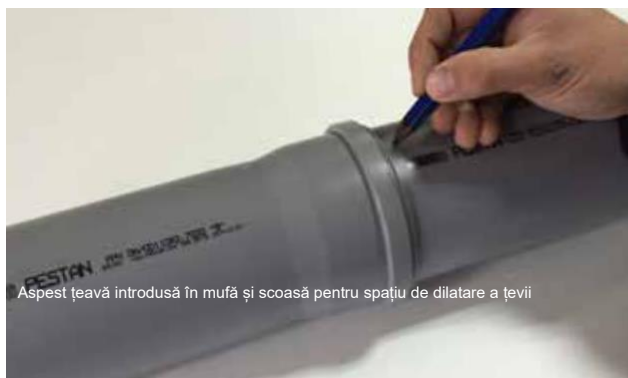
Aspect țeavă introdusă correct în mufă
