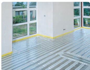
Panou Uponor ușor cu plăci radiante
