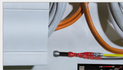
Conducte sub pardoseala
