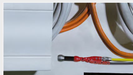
Conducte sub pardoseala
