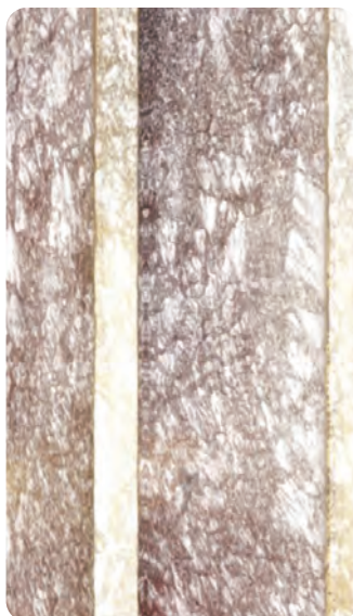
Gheață pe evaporator
